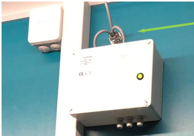
Kabeldurchführungen für die Elektrofilter und den Türkontaktschalter
