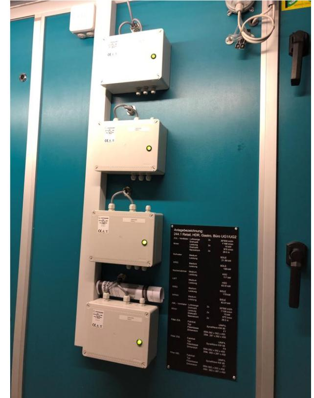
Anschlussbox direkt auf das Gerät montiert
